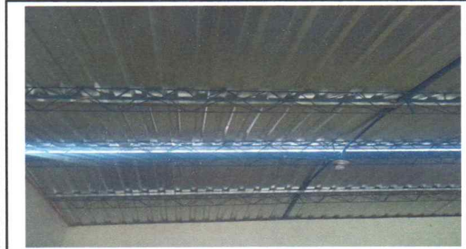
Foto 9: Sistema eléctrico instalado
