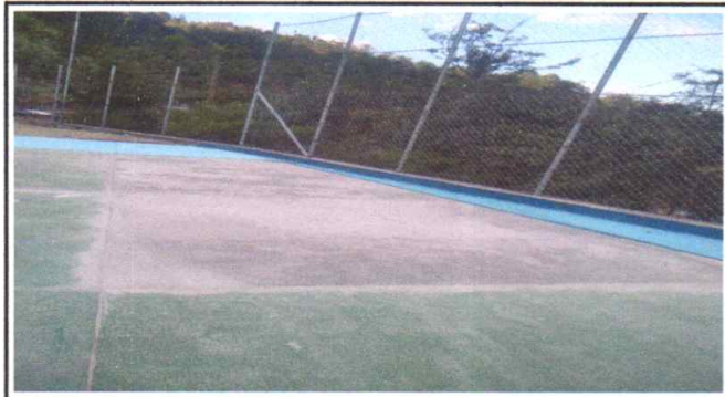
Foto 4: Torta de concreto culminada
