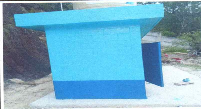
Foto 7: Pintura de pared de cocina y sanitarios aplicada
