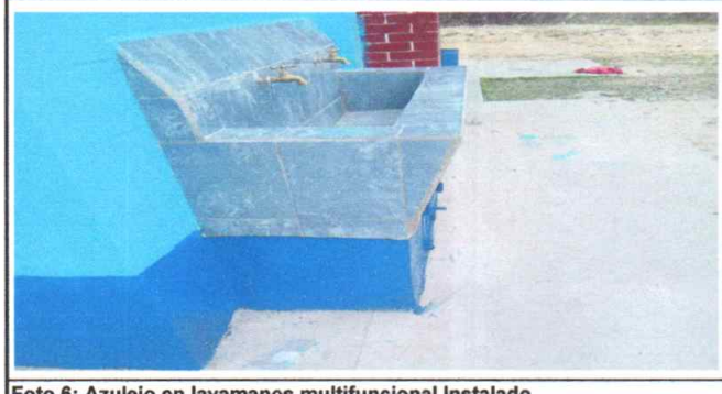
Foto 6: Azulejo en lavamanos multifuncional Instalado
