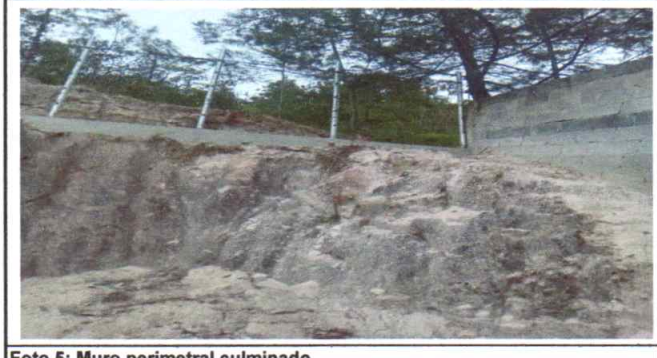
Foto 5: Muro perimetral culminado
