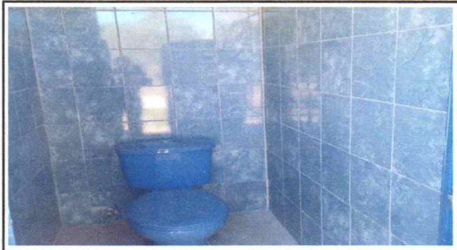
Foto 3: Tazas sanitarias instaladas
